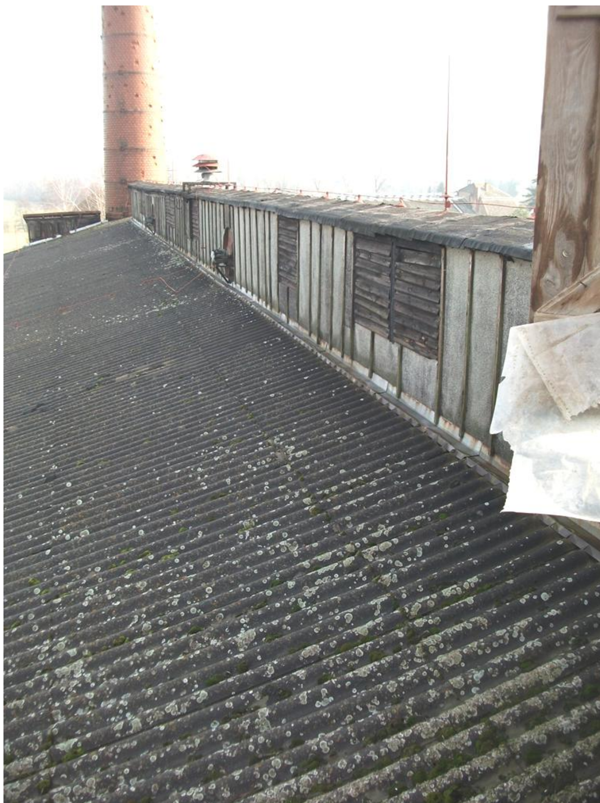
Celkový pohled na severní část střechy cihelny s původní provětrávací nástavbou
